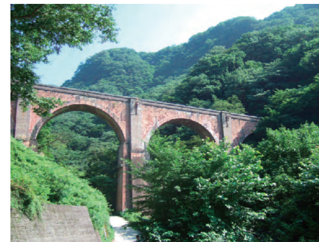
8-b 碓氷峠の隧道・橋梁群（群馬県安中市）
