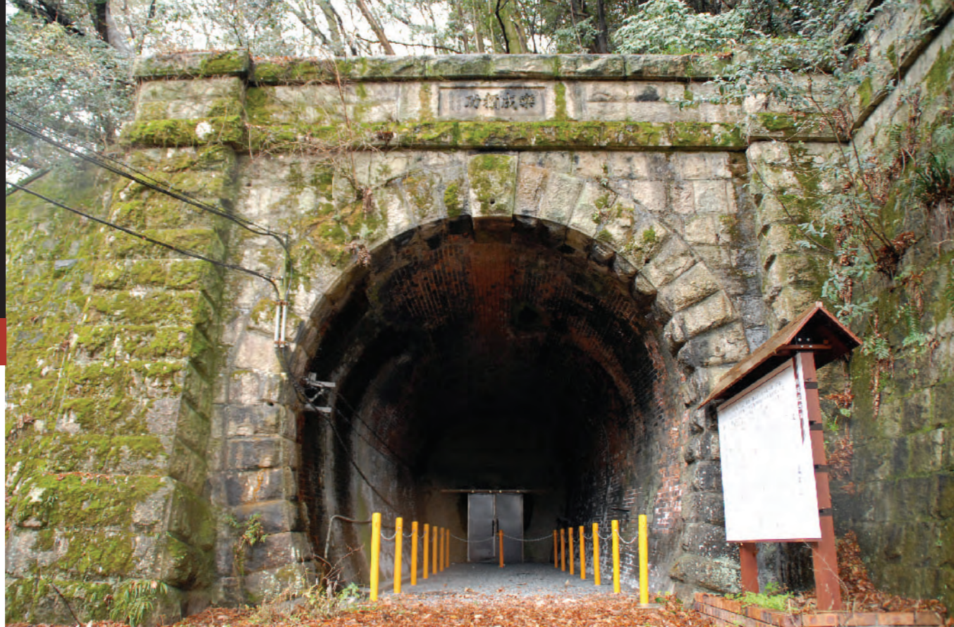
8-f 旧逢坂山隧道（東口）（滋賀県大津市）
