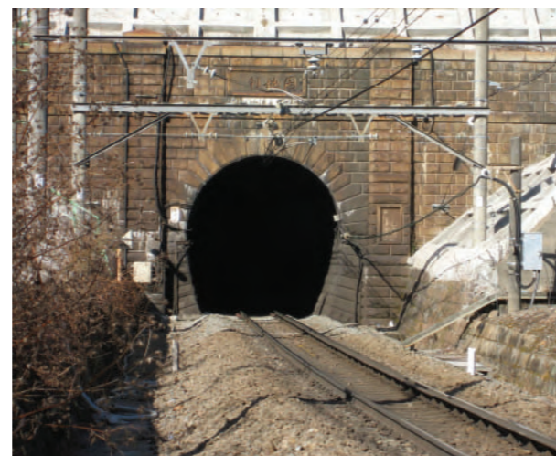
8-c 笹子隧道（山梨県大月市、甲州市）
