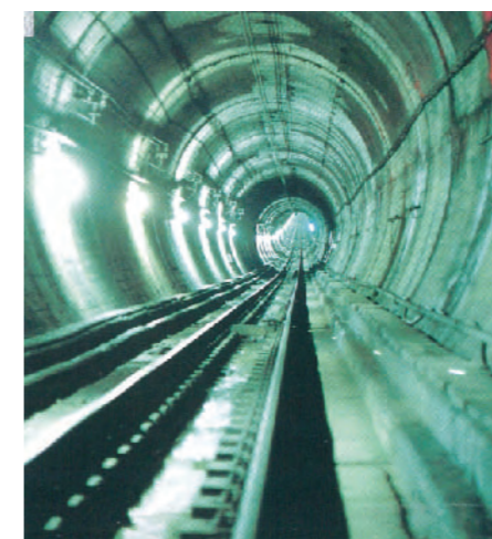
8-g 関門鉄道トンネル （山口県下関市、福岡県北九州市門司区）
