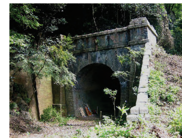
8-d 旧国鉄中央線の隧道群（愛知県春日井市）
